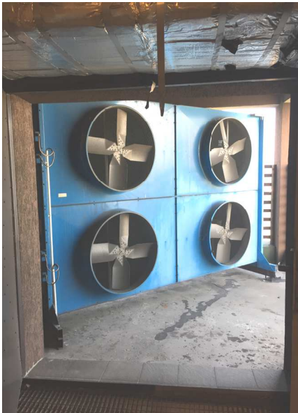
SKRAPLACZ WYTWORNICY WODY LODOWEJ - 4 PIĘTRO 3C
